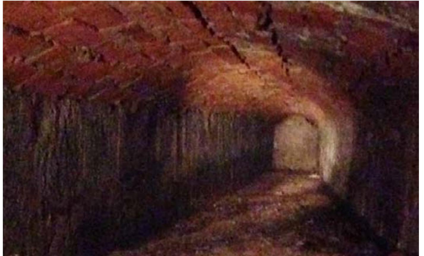
Akkurat gemauert mit Natursteinquadern und einem Gewölbe aus Klinkern, außerdem locker 150 Jahre alt: Der alte Abwasserkanal, den Bauarbeiter unter der Kurt-Schumacher-Straße gefunden haben.
