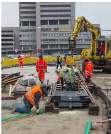
Die neue Weiche an der Kreuzung Lister Meile/ Rundestraße wird eingebaut.
