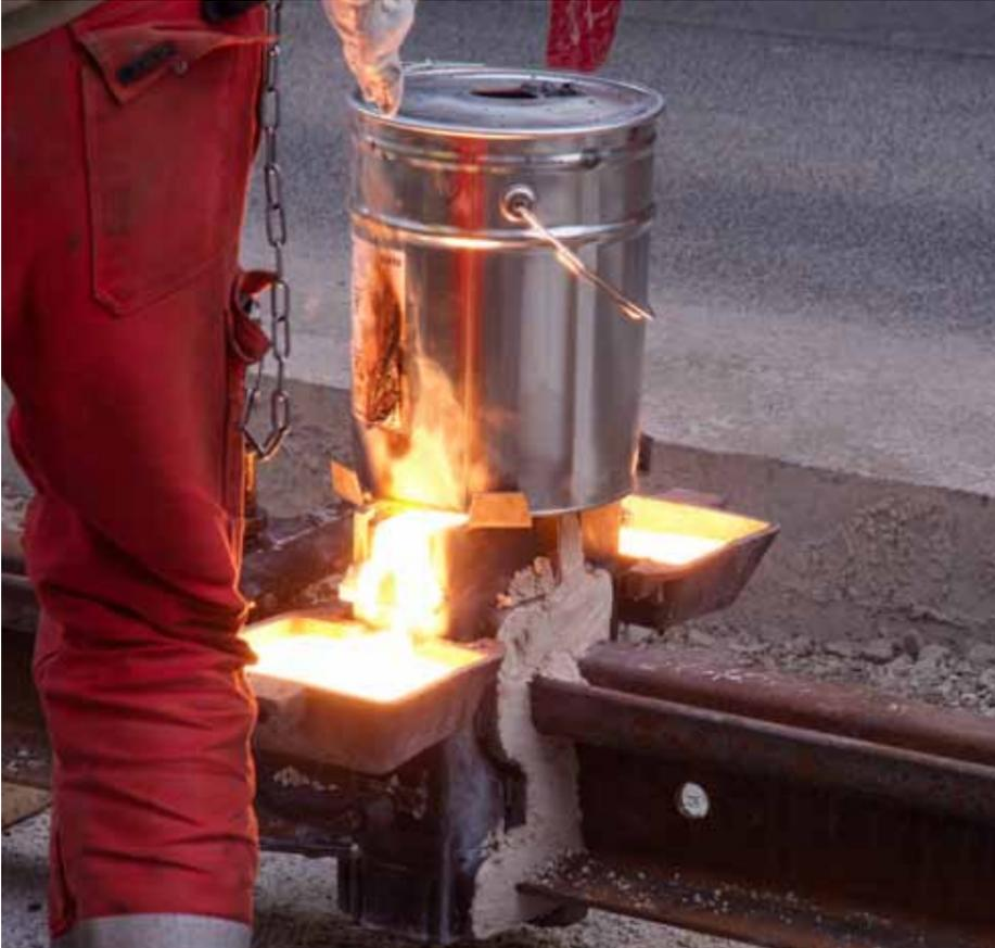
Kein Zaubertrank – es ist nur ein Blechimer mit Thermit gefüllt. Einem Gemisch aus Aluminiumgries und Eisenoxidpulver. Dort, wo zwei Schienen aufeinanderstoßen, wird er aufgesetzt und gezündet. Es dauert kaum länger als drei Minuten, dann sind die Schienenenden geschmolzen und eins geworden. Die Bahnen können später „rumpelfrei“ ihren Weg nehmen.
