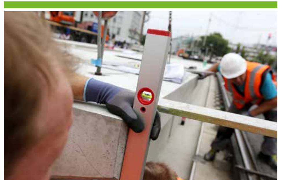
Höchste Konzentration: Millimetergenau müssen die vorgefertigten Einzelteile eingepasst werden.
