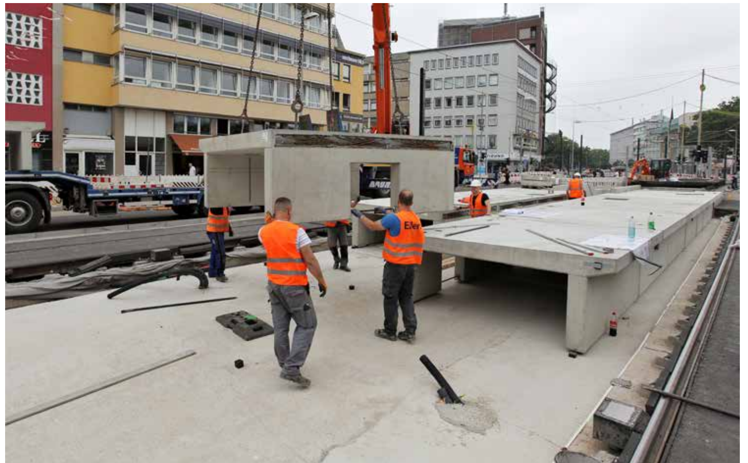
Mit einem Kran werden die schweren Fertigbauteile des Hochbahnsteiges vom Tieflader gehoben.
