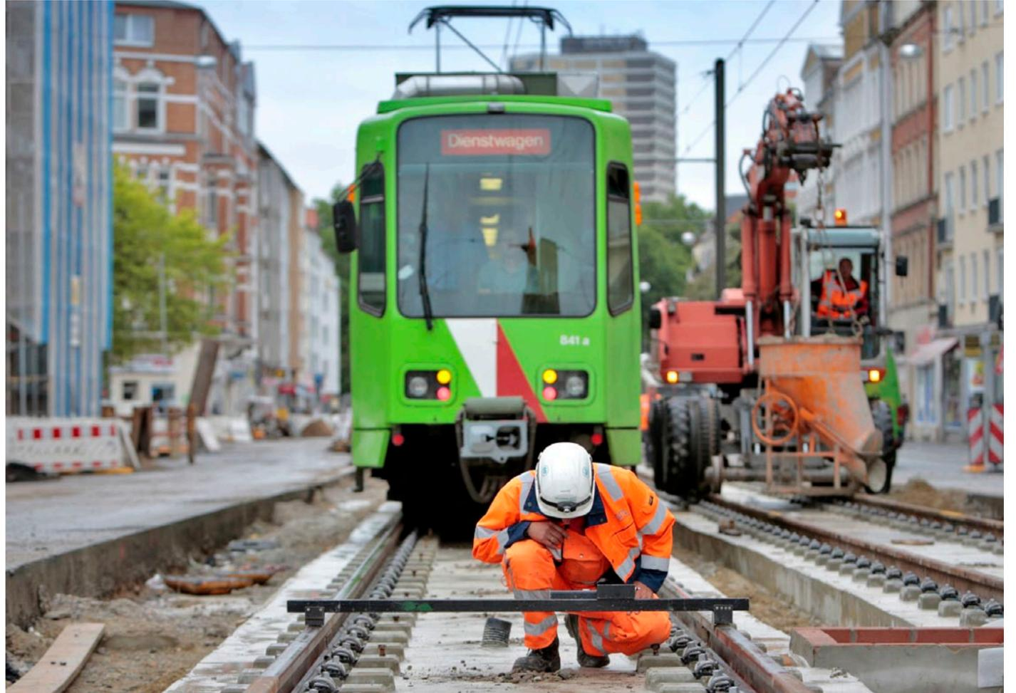
Noch eben schnell gucken, ob das Gleis gerade ist: Arbeiter mit Gleiswaage.
