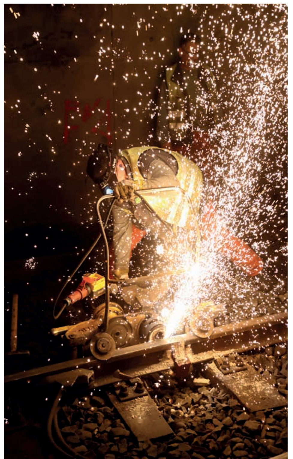
Bei Gleisreparaturen fliegen die Funken – nach Jahrzehnten ist ein Schienenaustausch notwendig
