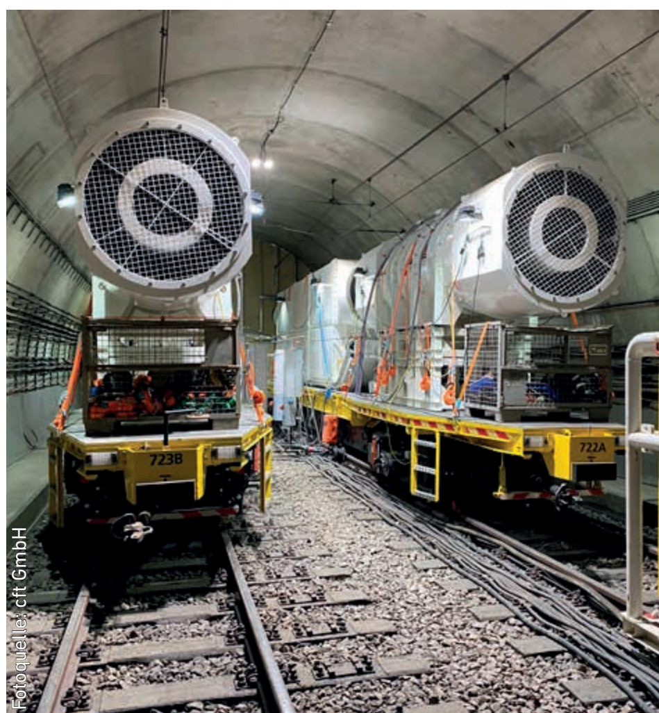
Solche Anlagen sorgen für frische Luft bei den Arbeiten im Tunnel.
