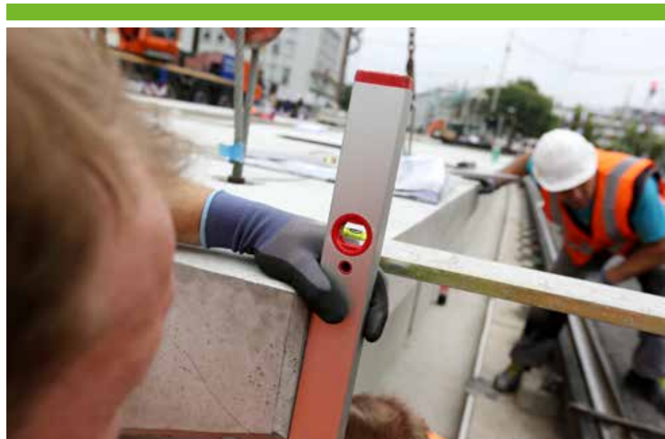
Höchste Konzentration: Millimetergenau müssen die vorgefertigten Einzelteile eingepasst werden.
