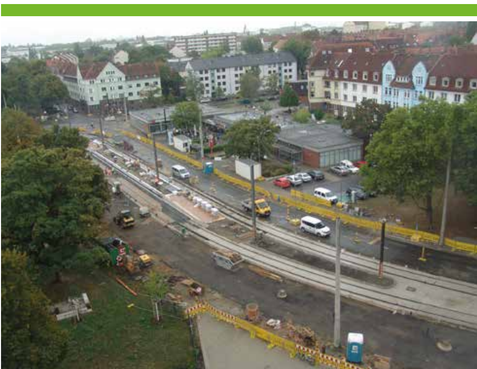
13. September 2018: Der Sommer geht langsam zu Ende. Der künftige Hochbahnsteig ist schon deutlich in der Straßenmitte zu erkennen.
