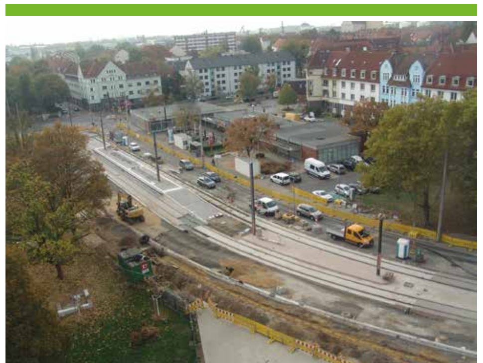
18. Oktober 2018: Der Hochbahnsteig wächst. Noch fehlen die Stahlaufbauten. Die Straße stadtauswärts wird hergestellt.
