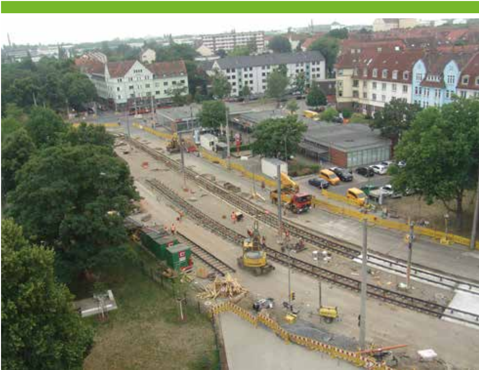
6. Juli 2018: In kurzer Zeit werden die neuen Schienenstränge so verlegt, dass der Hochbahnsteig den nötigen Platz bekommt.
