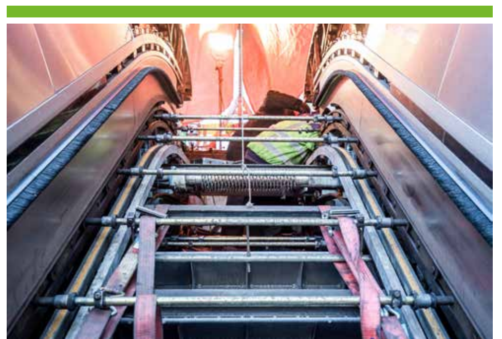
Das komplexe Innenleben der Rolltreppen wird regelmäßig gewartet.
