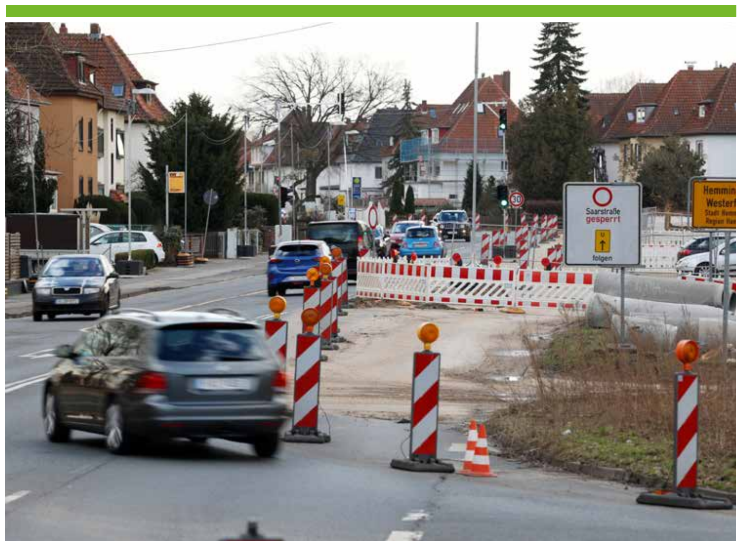
Im Sommer beginnt auch in Hemmingen die Verlegung der ersten Gleise.
