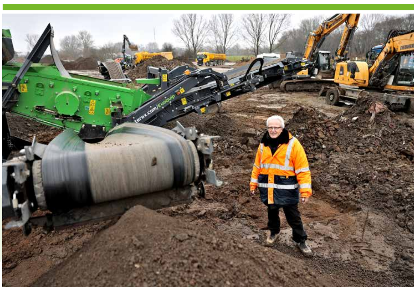
Gerrit Hahn erklärt die Anlage, mit der der ausgehobene Boden durchgesiebt wird, bevor die Analyse folgt.
