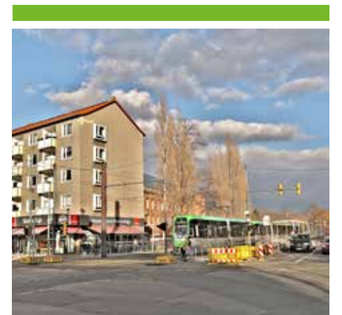
An der Wallensteinstraße werden Gleise erneuert und der Einbau der Weichen vorbereitet.
