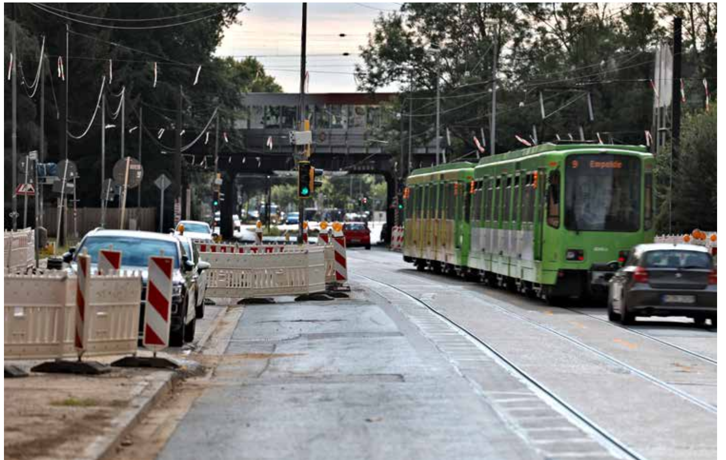
In der Badenstedter Straße müssen sich Stadtbahnen und Autos künftig den Platz nicht mehr teilen.
