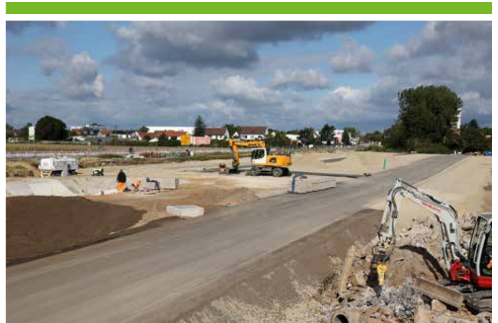
Die alte Müllhalde ist beseitigt. Jetzt wird hier der Endpunkt gebaut.
