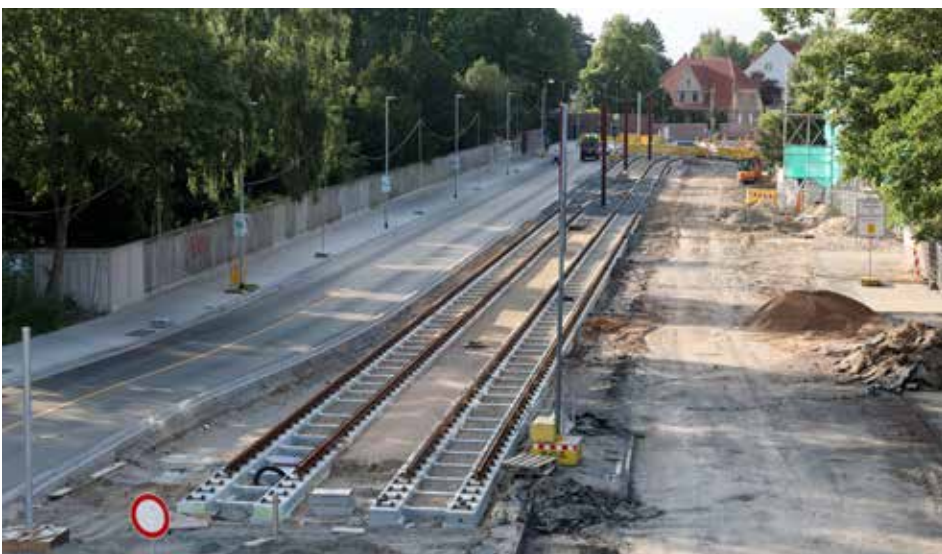
Bis in Höhe des Stadtfriedhofs Ricklingen sind die Schienen verlegt.
