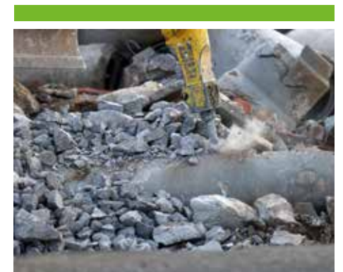
Alte Betonteile werden zerkleinert.
