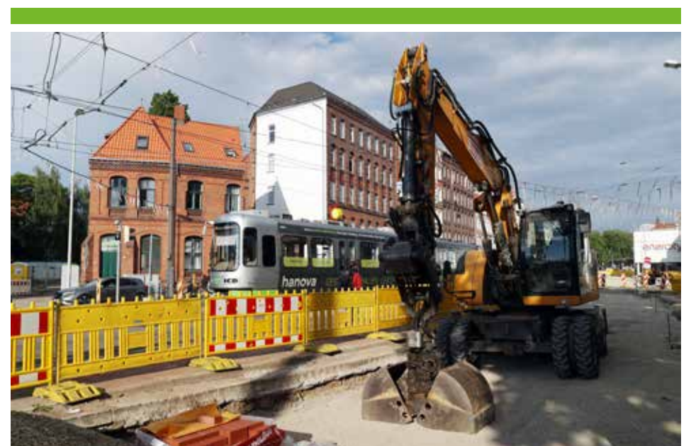
Die Absperrbaken werden noch länger das Bild der Braunstraße prägen
