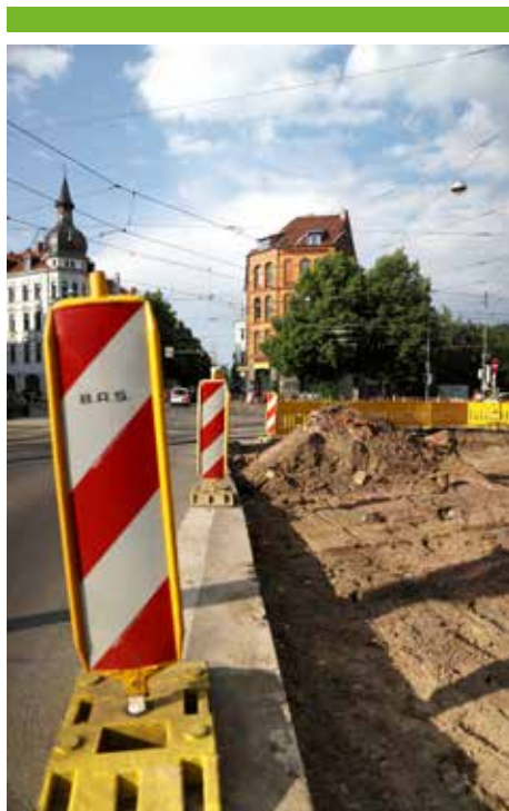
Der Boden für die Gleise ist bereit
