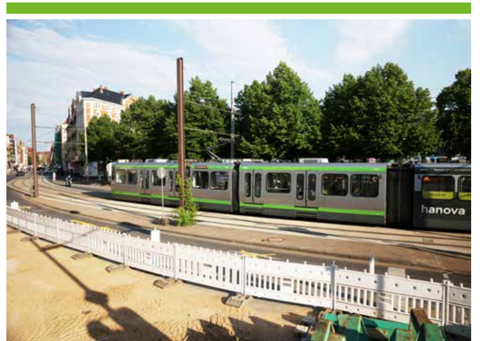
Die Stadtbahn wird die Baustelle künftig eingleisig passieren
