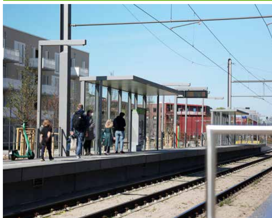
Die Haltestelle Kurze-Kamp-Straße ist seit Dezember 2021 barrierefrei nutzbar.
