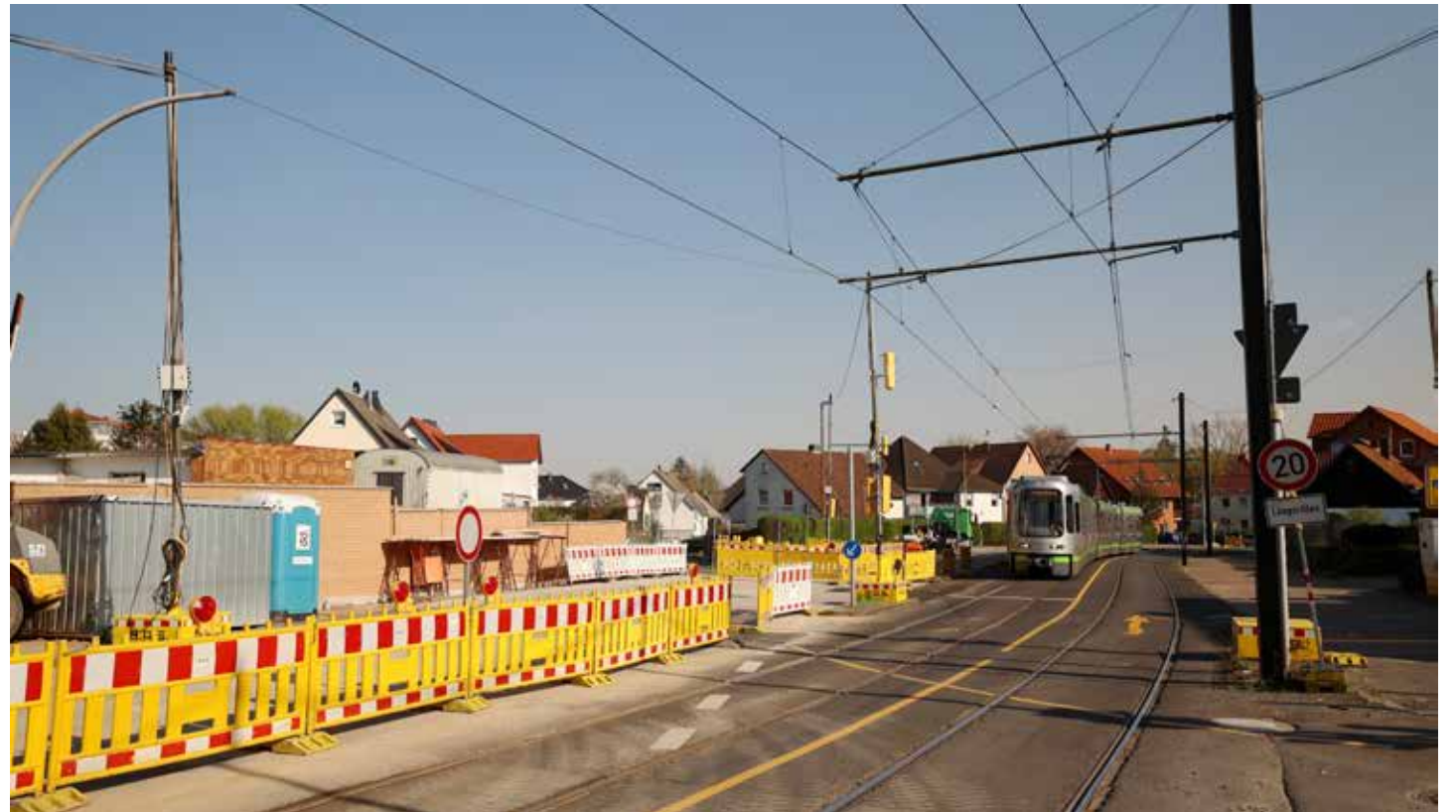
Damit der Hochbahnsteig Rethen/Pattenser Straße gebaut werden kann, muss die Hildesheimer Straße gesperrt werden.
