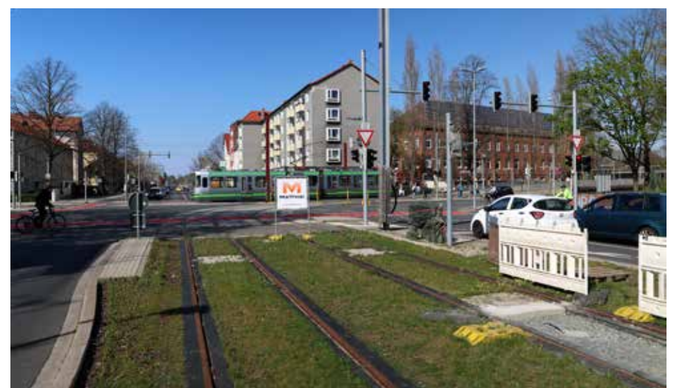
In Oberricklingen wird der Anschluss an das Stadtbahnnetz hergestellt.
