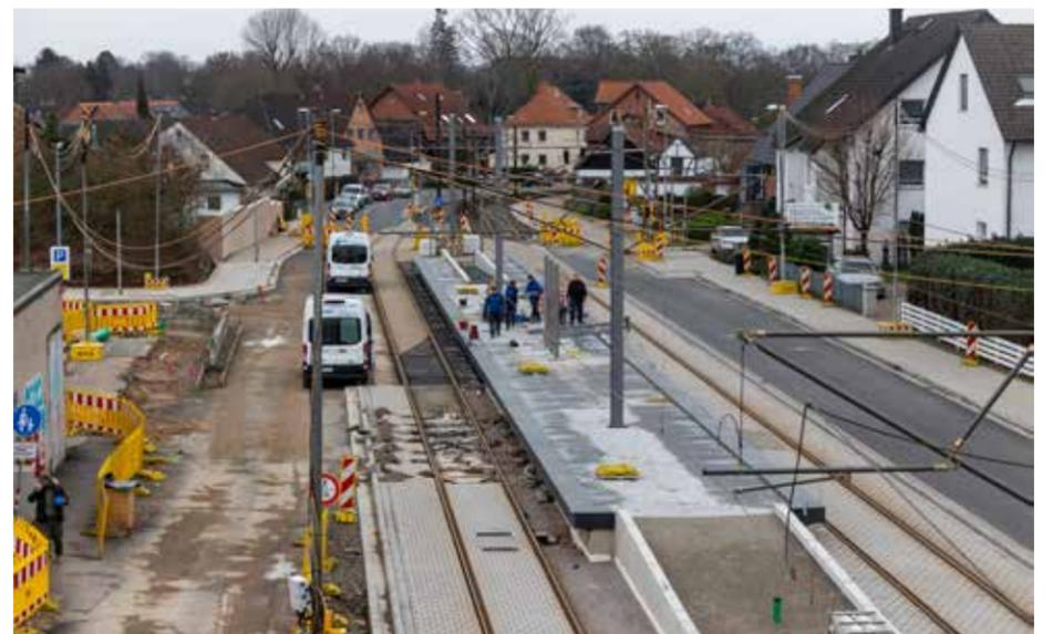
Auf dem Bahnsteig werden die Aufbauten errichtet, gleichzeitig wird die Straße hergestellt.
