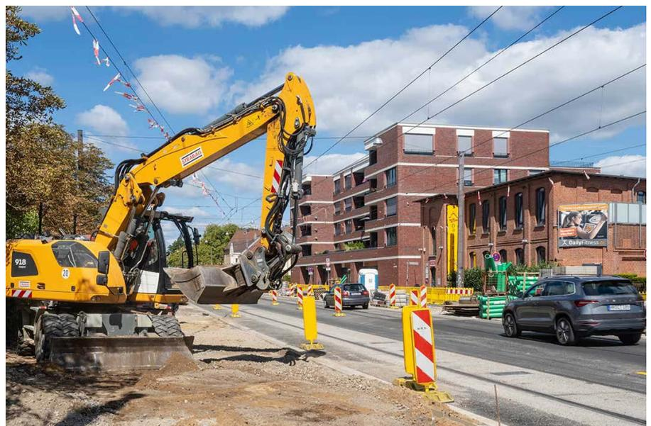
Das bisherige stadtauswärtige Gleis wird nunmehr entfernt, anschließend werden hier Kanäle verlegt. Die Arbeiten werden bis zum Frühjahr 2026 andauern. Während der Osterferien 2026 bis einschließlich Gründonnerstag erfolgen weitere Gleisbauarbeiten für das neue stadtauswärtige Gleis sowie das Einsetzen der Fertigbauteile für den Hochbahnsteig. Über die Osterfeiertage selbst sind keine Bauarbeiten geplant.
