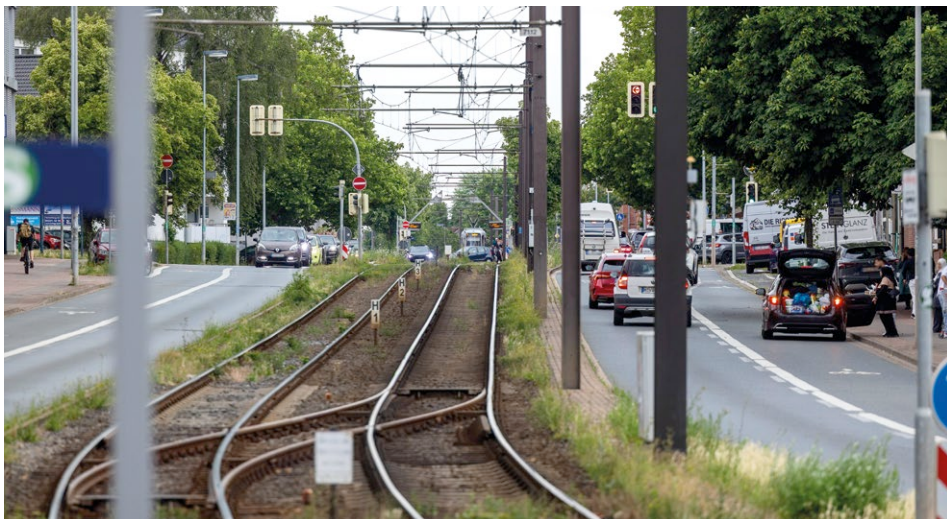
Während der Sanierung wird die Spur an den Gleisen gesperrt, Autos fahren auf der Velo-Route.
