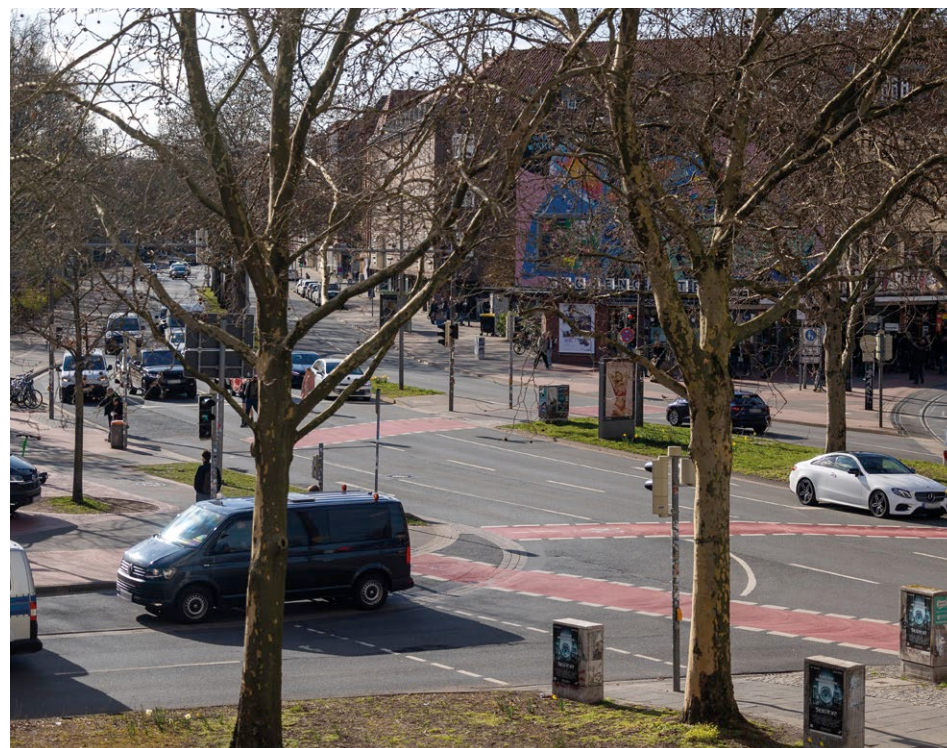
Während der Bauarbeiten enden die Stadtbahnen vor dem Küchengarten.
