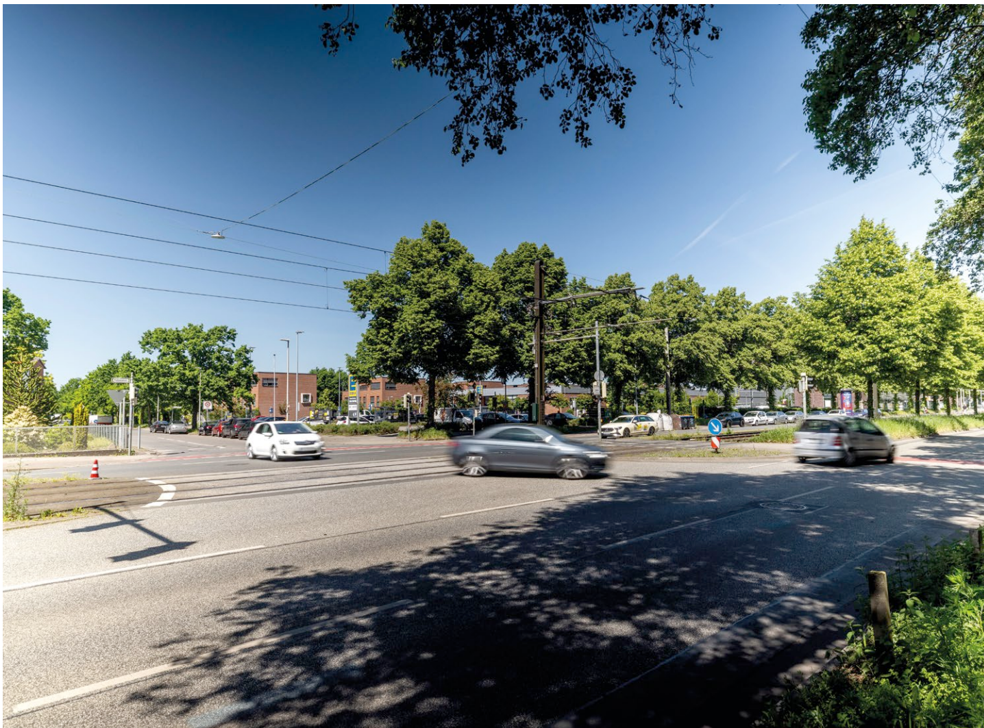
Die Überfahrt Grethe-Jürgens-Straße wird saniert. Auch die Gleise in Richtung Spannhagengarten werden erneuert.
