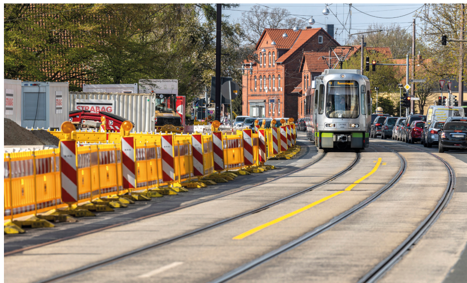
In der nächsten Bauphase beginnt der Bau eines neuen Gleises stadteinwärts.
