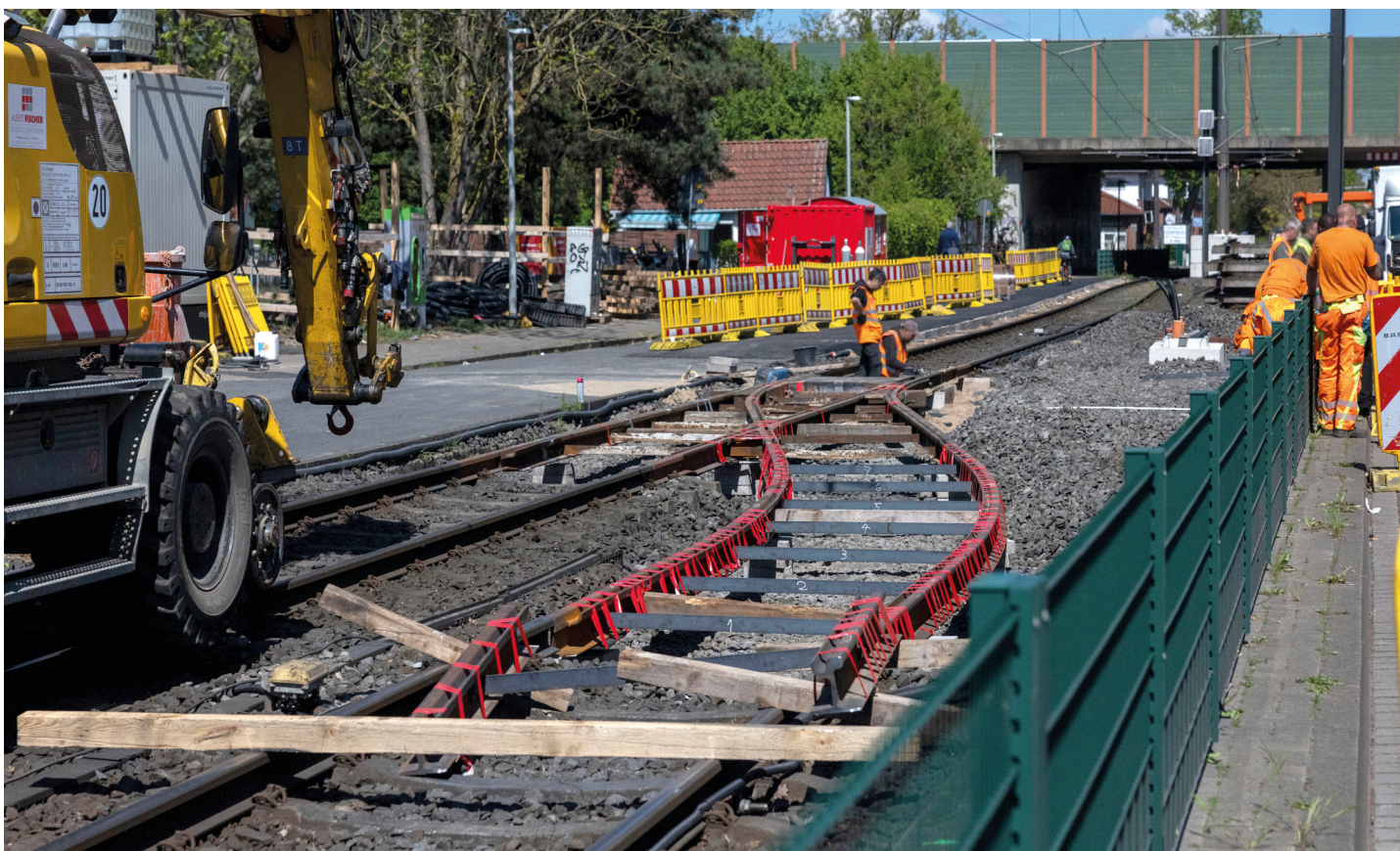
Nach dem Einbau einer Weiche können die Stadtbahnen vor dem Endpunkt Fasanenkrug die Richtung wechseln.
