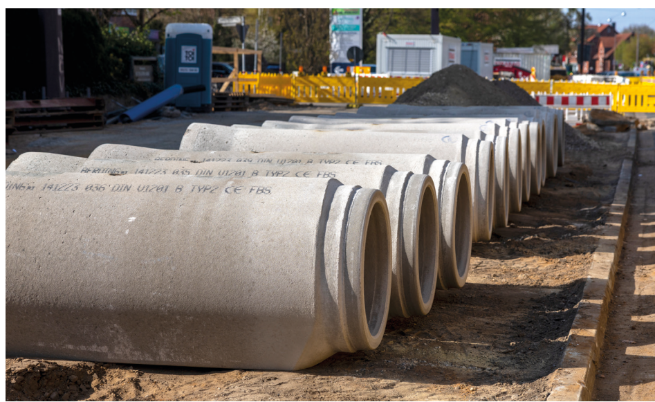
Kanäle und Leitungen werden außerhalb der Haltestelle neu verlegt.
