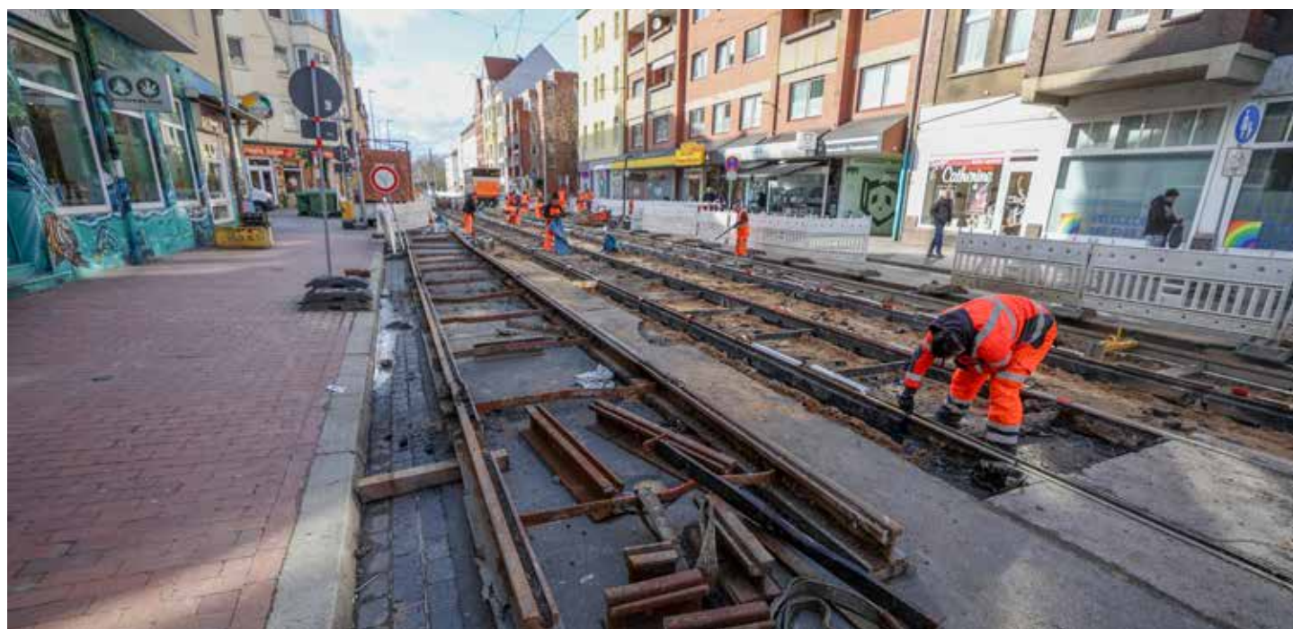
Baustelle: In der Limmerstraße in Linden werden die Gleise am Hochbahnsteig der Haltestelle Freizeitheim Linden fertiggestellt.
