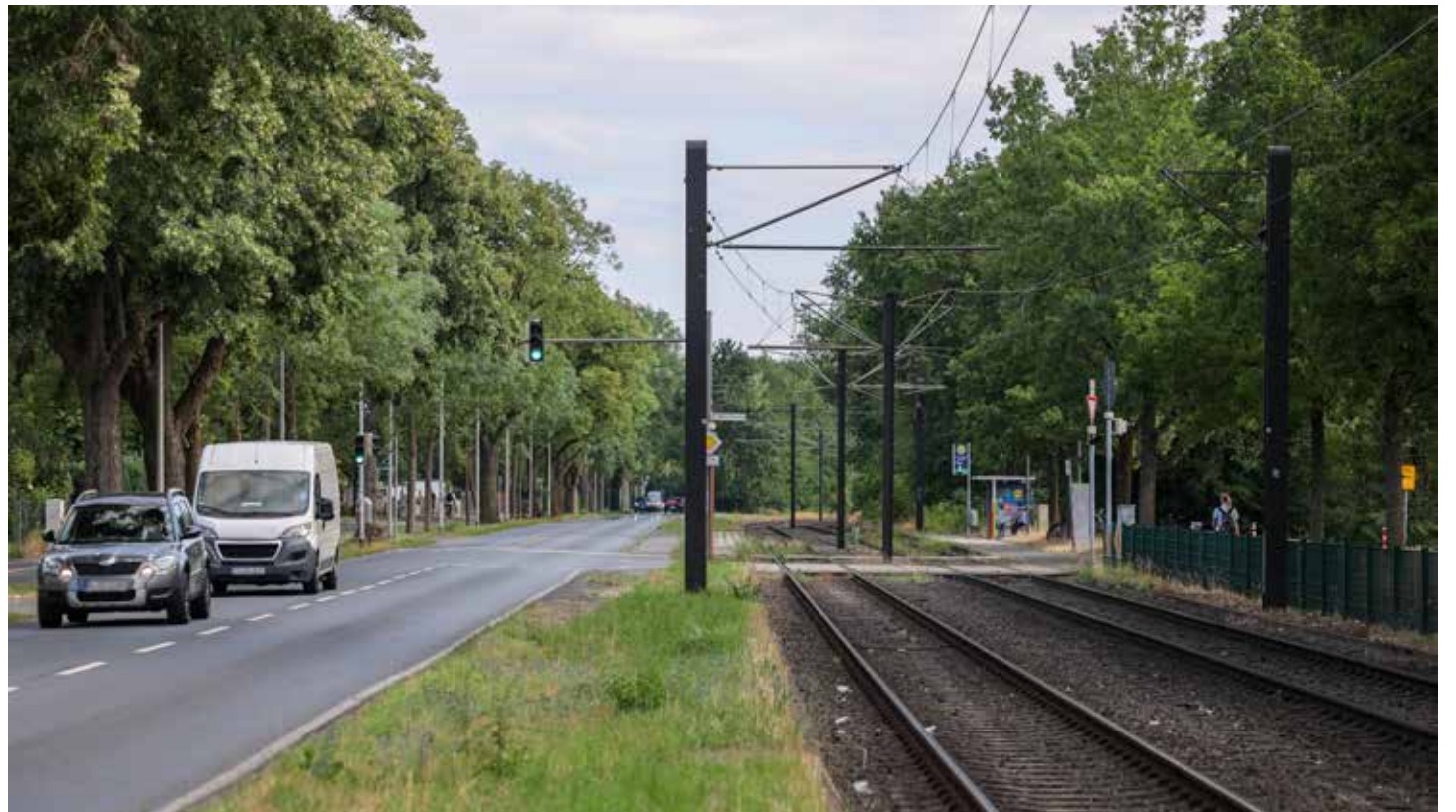
Die Haltestelle Stadtfriedhof Bothfeld wird verlegt, die Seitenhochbahnsteige entstehen nördlich der Einmündung Eichhörchensteg.
