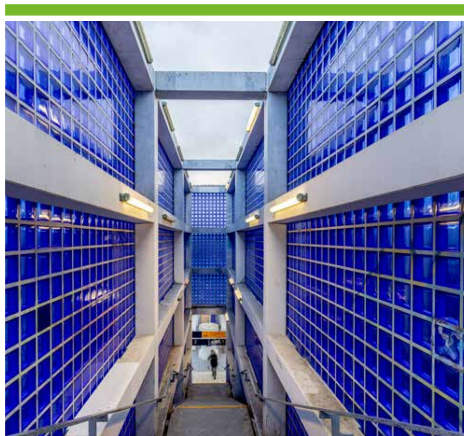
Der S-Bahnhof Nordstadt wurde anlässlich der Weltausstellung Expo 2000 gebaut
