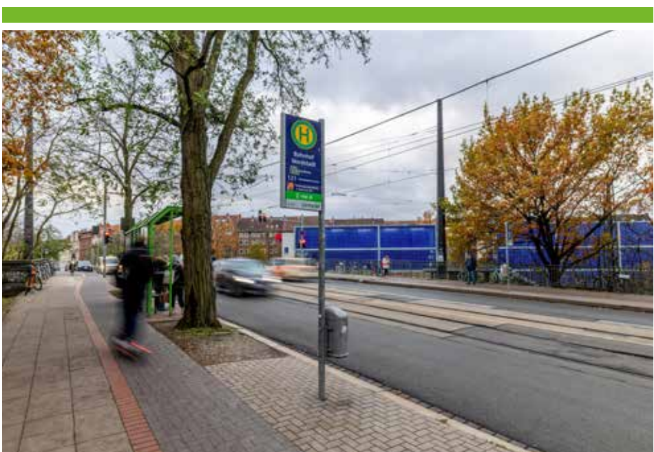
Nebenanlagen und Fahrbahn im Haltestellenbereich werden neu gestaltet.
