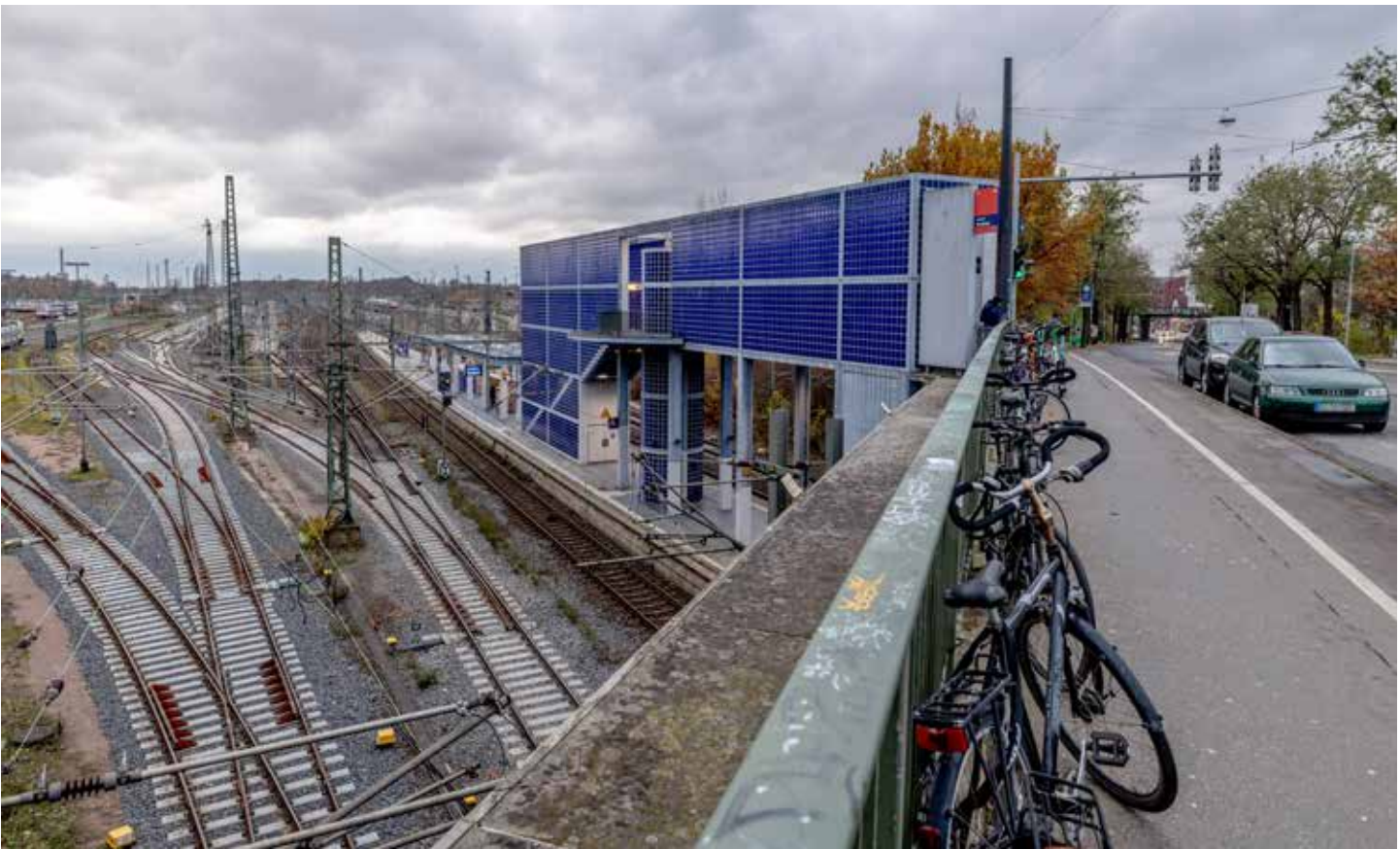
Für den Rad- und Fußverkehr auf der Straßenbrücke, von der aus der S-Bahnhof erreichbar ist, wird mehr Platz geschaffen
