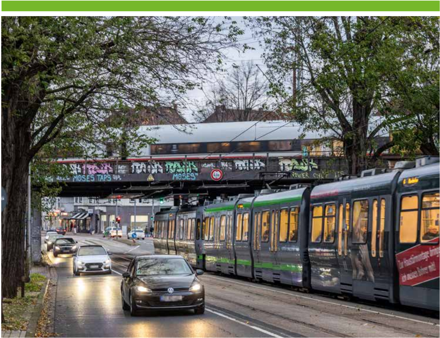
Der Bau der neuen Eisenbahnüberführung und des Hochbahnsteiges werden eng abgestimmt
