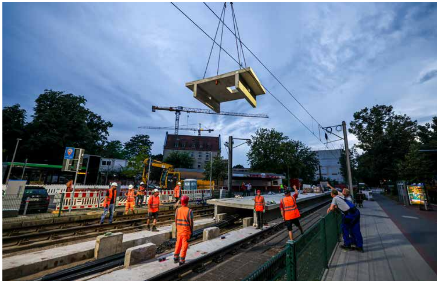
Am Ausleger eines Krans schweben die Bauteile für den Hochbahnsteig ein und werden platziert
