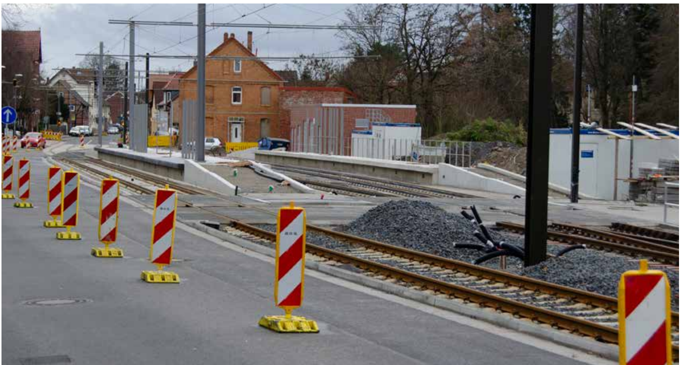
Der Hochbahnsteig in Gleiding – aus Fertigteilen zusammengesetzt.
