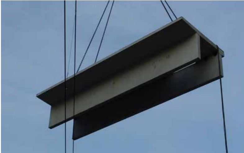
Hier schwebt ein Hochbahnsteigteil vom LKW an seinen Platz.
